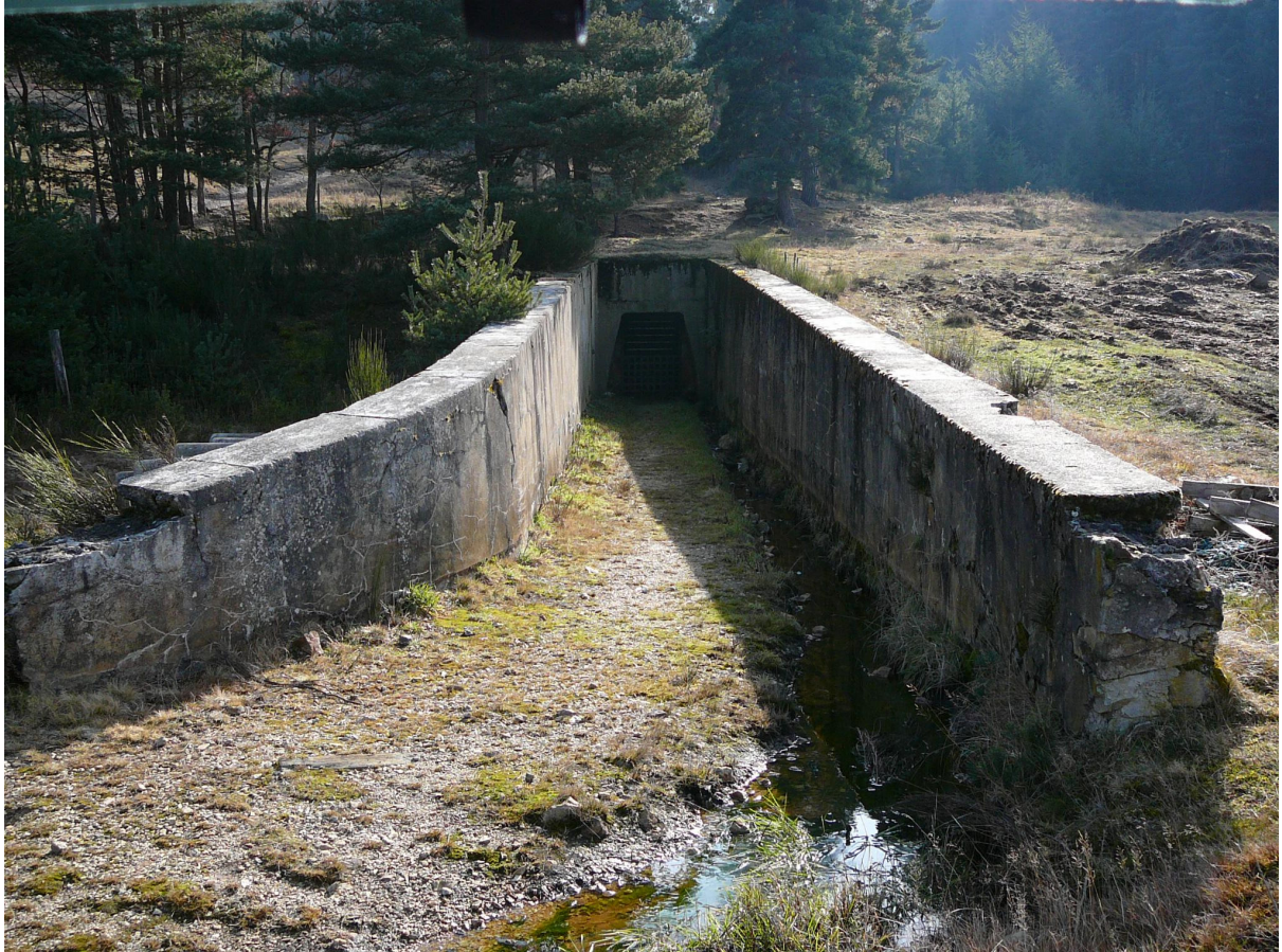
Au-delà du terminus, une des entrées du monde souterrain, déconnectée de la ligne de Langeac, avec un écartement de 0,40m (Photos R. DAVID du 30/01/08).
