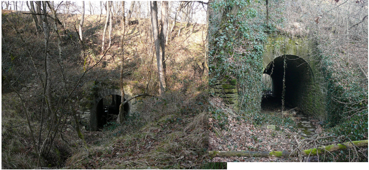
Images de pont en maçonnerie, cachés au bas des talus. Le chemin de fer longeait un vallon et coupait de petits cours d'eau. Aller à leur rencontre relève de l'exploit, sauf lorsque la végétation n'est pas trop développée. (Photos R. DAVID du 30/01/08)
